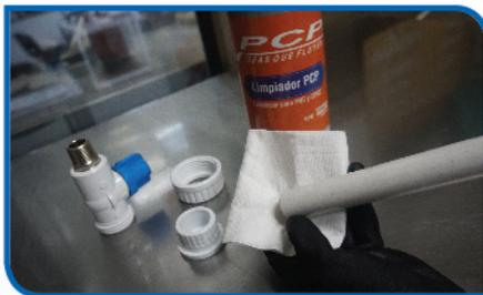
2. Limpie las superficies a soldar, el exterior del tubo y el interior del accesorio PCP.
