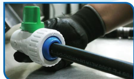
5. Tome el cuerpo del registro e introduzca el tubo. Asegúrese que el tubo llegue hasta el tope interno del cuerpo del registro.
