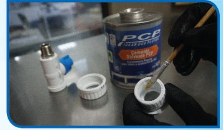
4. Una el accesorio PCP y el tubo con un ligero movimiento de torsión, ¼ de vuelta y mantenga sostenido. Siga las recomendaciones e instrucciones contenidas en la etiqueta de la soldadura para PVC, **PCP**
